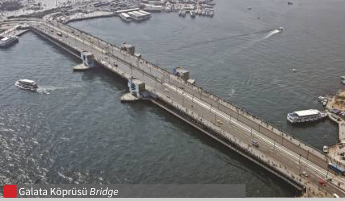
Galata Köprüsü Bridge
